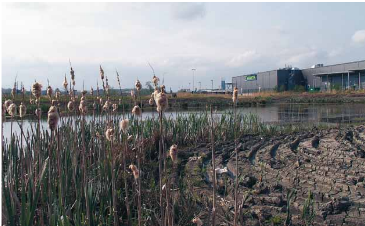
En dagvattendamm kan minska påverkan från till exempel parkeringsplatser och industriområden genom att ta hand om en del av de gifter och näringsämnen som annars skulle läcka ut i närliggande vattendrag. Foto: Hans Oscarsson
