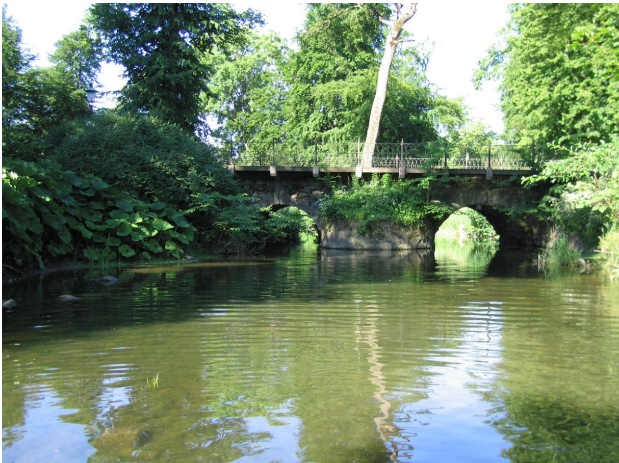
1800-talsbro vid Trolldenäs slott. Foto Vibeke Lirås, Länsstyrelsen Skåne 2005.
