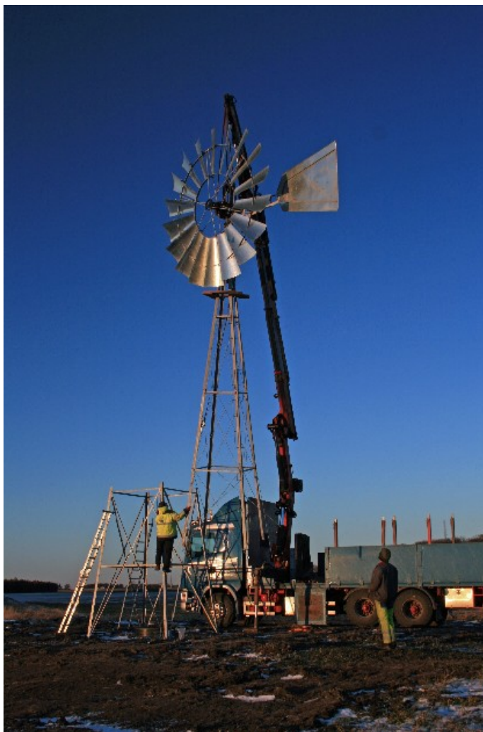
Bild 6 Resning av torn med rotor
