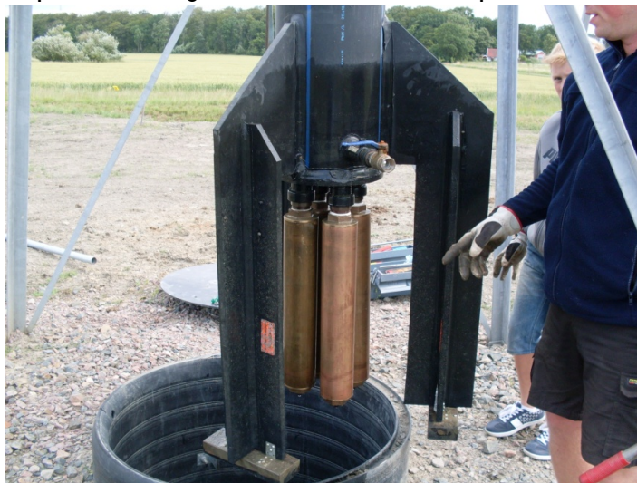
Bild 8 Montage av "Brunnsraket" (Foto: Kenny Hansson)
