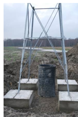
Bild 5 Vindpumpstorn vid montering
