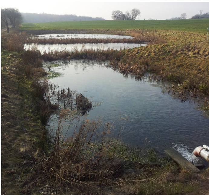
En idealisk näringsfälla söder om Århus i Danmark med tre tvärställda grundområden som bromsar vattenflödet och ökar sedimentationen.
