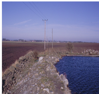
Bevattningsdamm i Skåne med en brant vall och stor steninblandning. Risken för vallbrott är stor.
