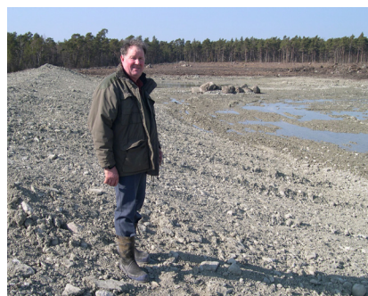
En säker bevattningsdamm på Gotland med flacka slänter som även gynnar växt- och djurliv.
