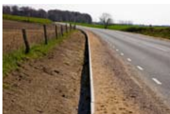
Barriär längs väg som hindrar groddjur att komma upp på vägen och istället styr dem mot en grodtunnel. Foto: Anders Hallengren
